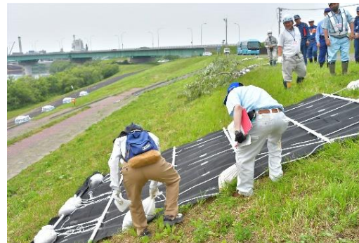
シート張り工
