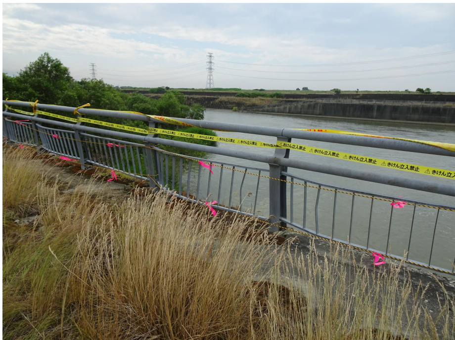
○撮影場所：清幌床止(夕張川KP=9.0) ○写真説明：立入禁止テープによる立入規制
