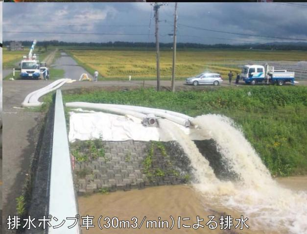
排水ポンプ車(30m<sup>3</sup>/min)による排水
