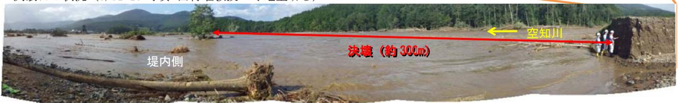
図 2-18 上流決壊箇所の被災状況
