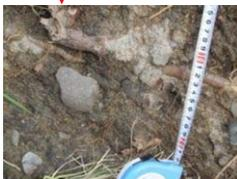
堤内から堤外へ氾濫水が戻る際の流水で浸食したものと思われる。植生が薄くなった堤防は礫が露出。
