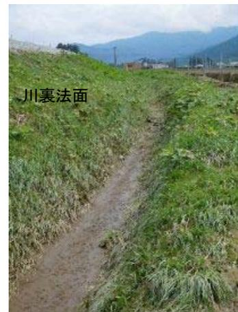
B: 決壊口上流側付近の堤内状況（噴砂の痕跡無し）
