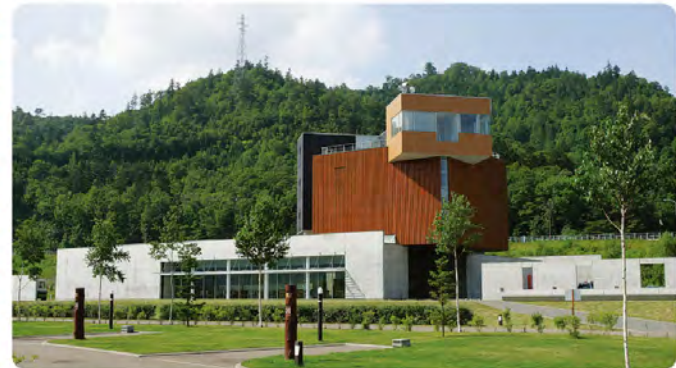
滝里ダム防災施設
