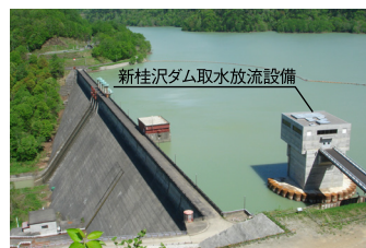
新桂沢ダム取水放流設備運用開始(H26年3月)
