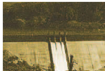
桂沢ダム完成(S32年)
