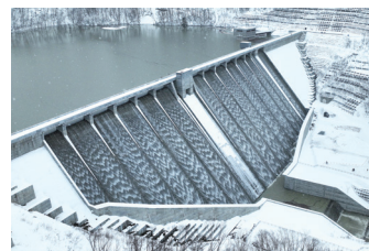
試験湛水の状況(R5年12月)
