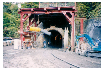
三笠ぼんべつダム仮排水路トンネル工事(H13年)
