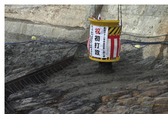
打設開始(H29年7月)
