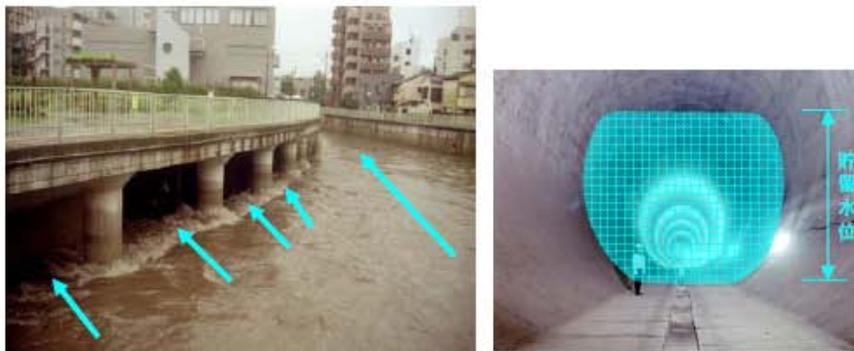
洪水調節施設の整備(地下調整地)
