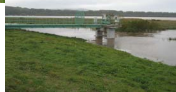
【平成18年10月出水における外水位状況】
