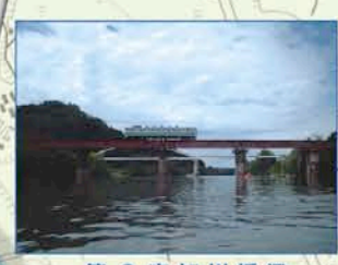
第3空知川橋梁
