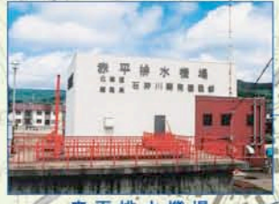
赤平排水機場
