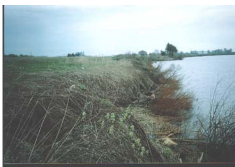
工事着手前の状況
