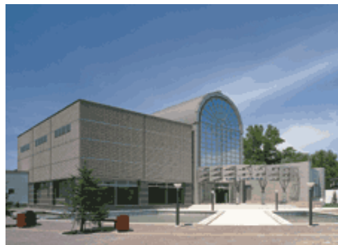
「下水道科学館」 (札幌市) 下水道の歴史、役割、仕組みなどを紹介
