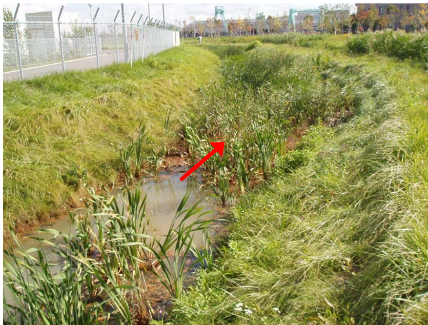
丘珠5号川（河川水が停滞している状況）
