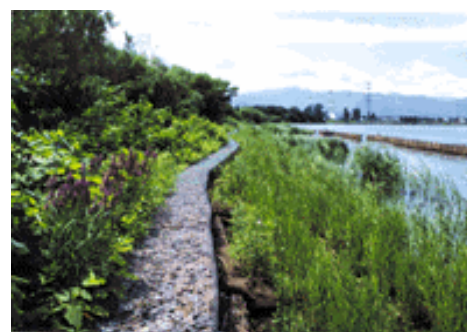
工事着手後の状況
