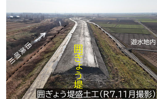
■盛土工(囲ぎよう堤)
