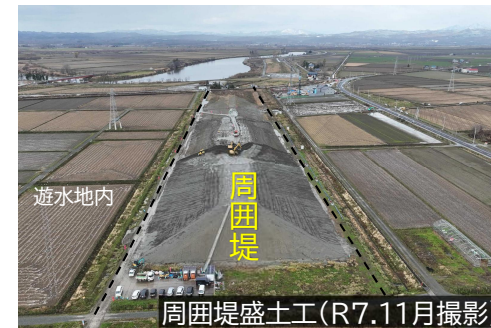
■盛土工(周囲堤)
