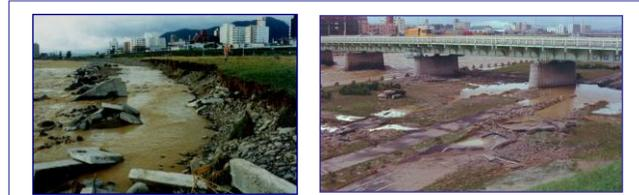
河岸の洗掘状況（南大橋上流左岸） 高水敷の洗掘状況（幌平橋直下流左岸）
