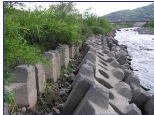
河床洗掘により低下した既設護岸
