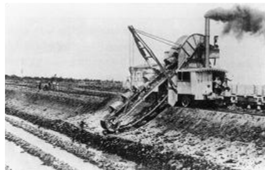
捷水路の陸上掘削 (ラダーエクスキャベーター)
