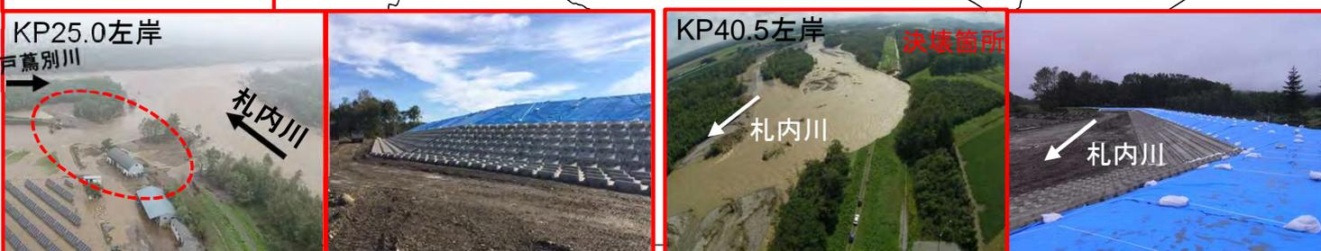
札内川KP25.0左岸(L=200m)およびKP40.5左岸(L=200m)の堤防が決壊
