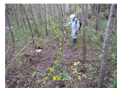
地すべり地内の市道脇法面の亀裂
