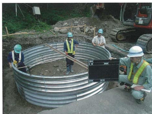
対策工施工 (集水井工施工) 事例※2
