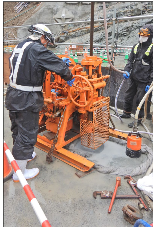
ボーリング状況
