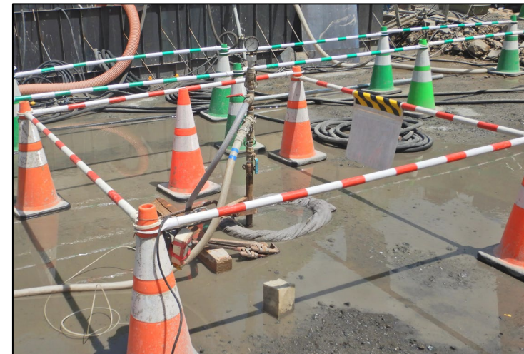
セメントミルク注入状況
