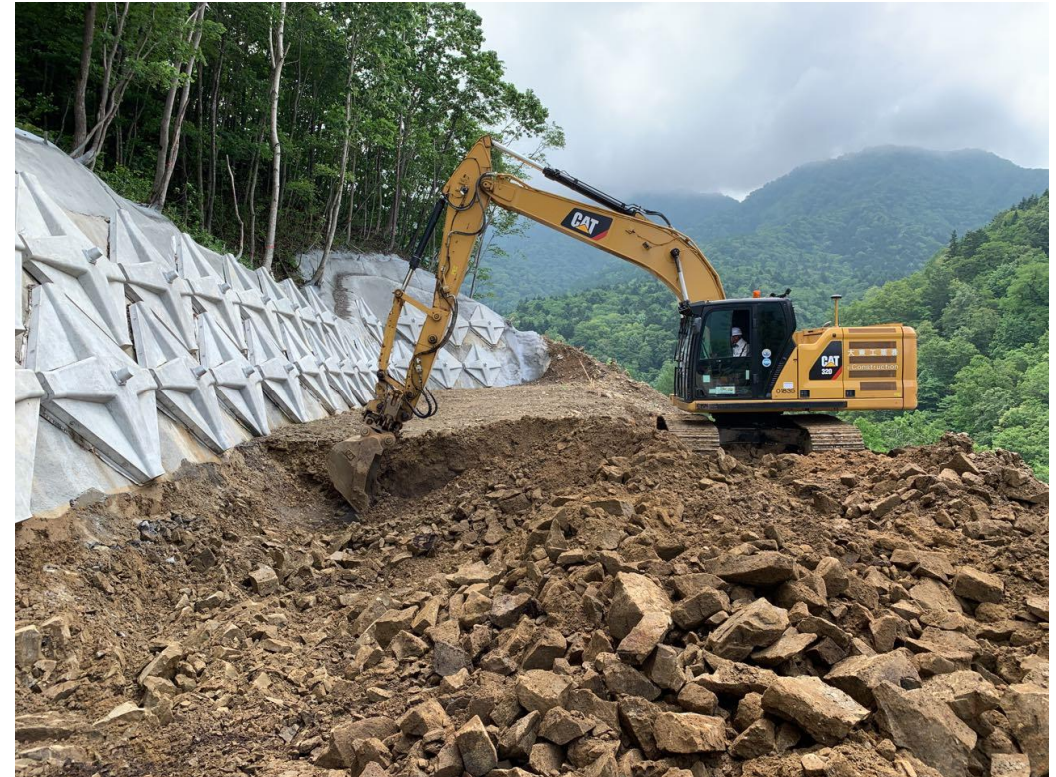
管理用道路工事 掘削工(R4.7撮影)
