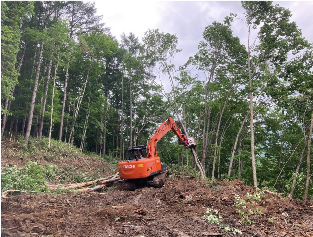
管理用道路工事 伐開工(R4.7撮影)
