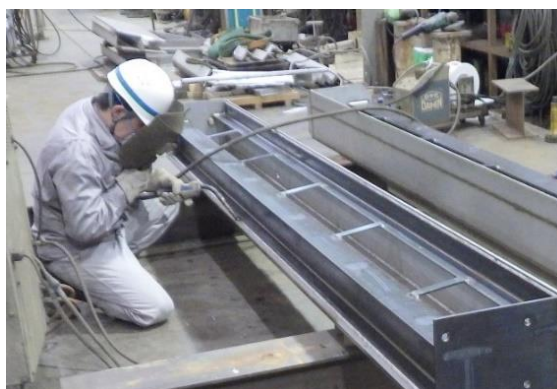
第1常用洪水吐ゲート 溶接 令和3年8月撮影
