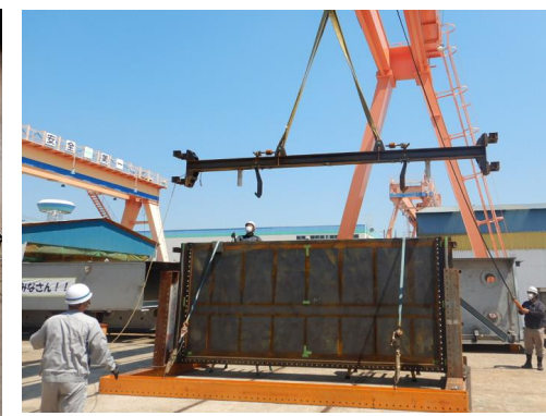
試験湛水ゲート 工場検査 令和4年6月撮影
