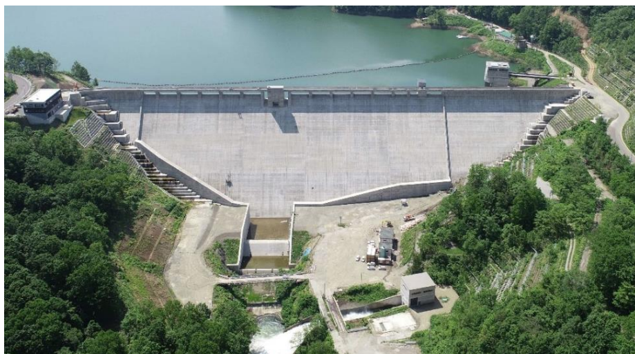
新桂沢ダム堤体本体 令和3年6月撮影
