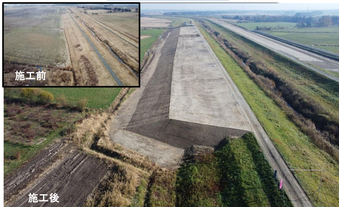
音江別川(堤防整備)
