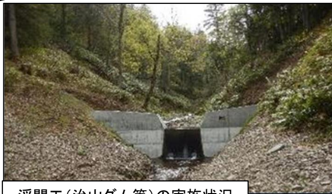
溪間工(治山ダム等)の実施状況
