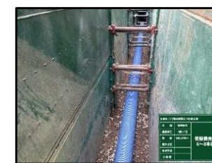
【雨水管敷設状況】
