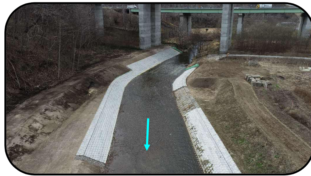
島松川(実施後)
