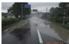
平成26年8月洪水 （国道275号冠水状況）
