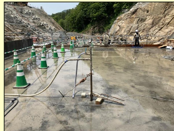
地盤条件による、グラウチング範囲や施工量の変更 等
