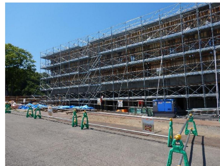
施工状況 (R8年6月撮影)
