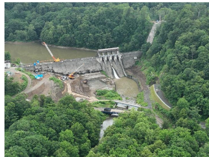
ダム下流施工状況 (R8年7月撮影)
