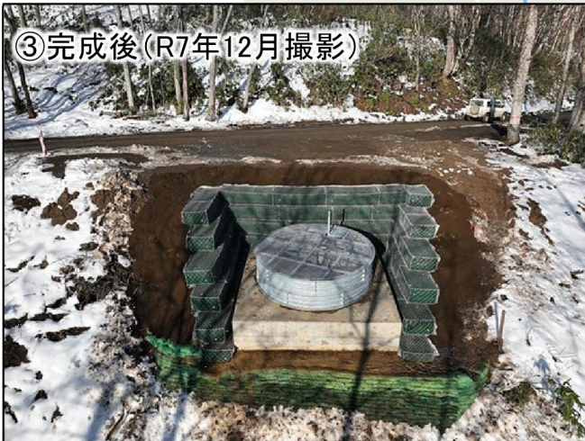
③地すべり対策工事○
