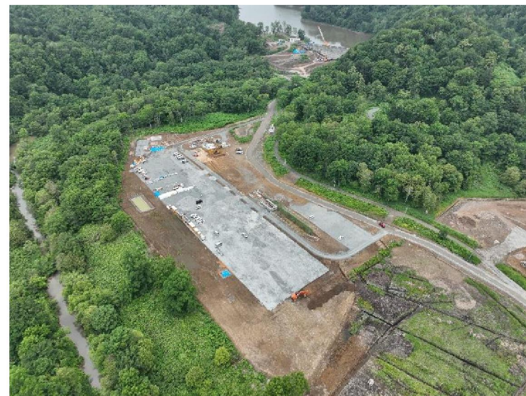
仮設備設置状況 (R8年7月撮影)
