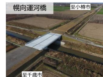
橋 長:25m 橋梁形式:PC単純中空床版橋 逆T式橋台
