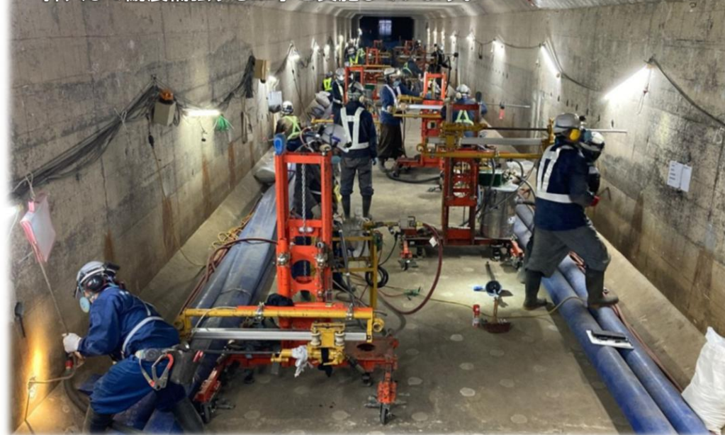
【美沢川函渠耐震補強 施工状況】
