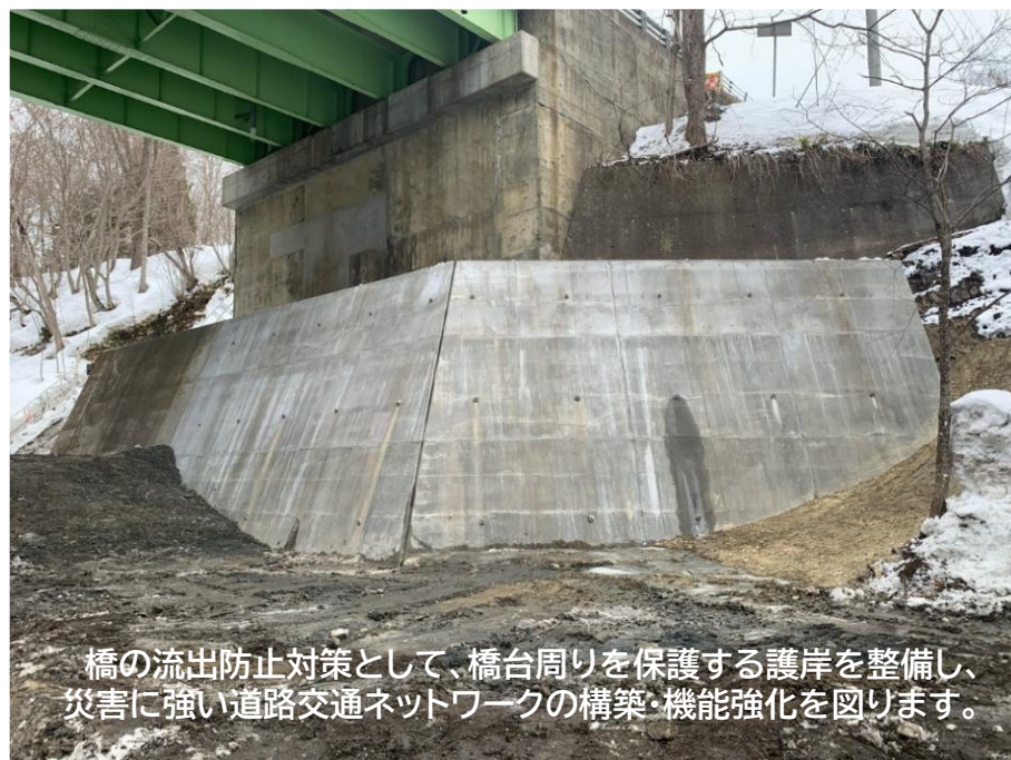
【道路構造物の流失防止対策(橋台の護岸整備)】
