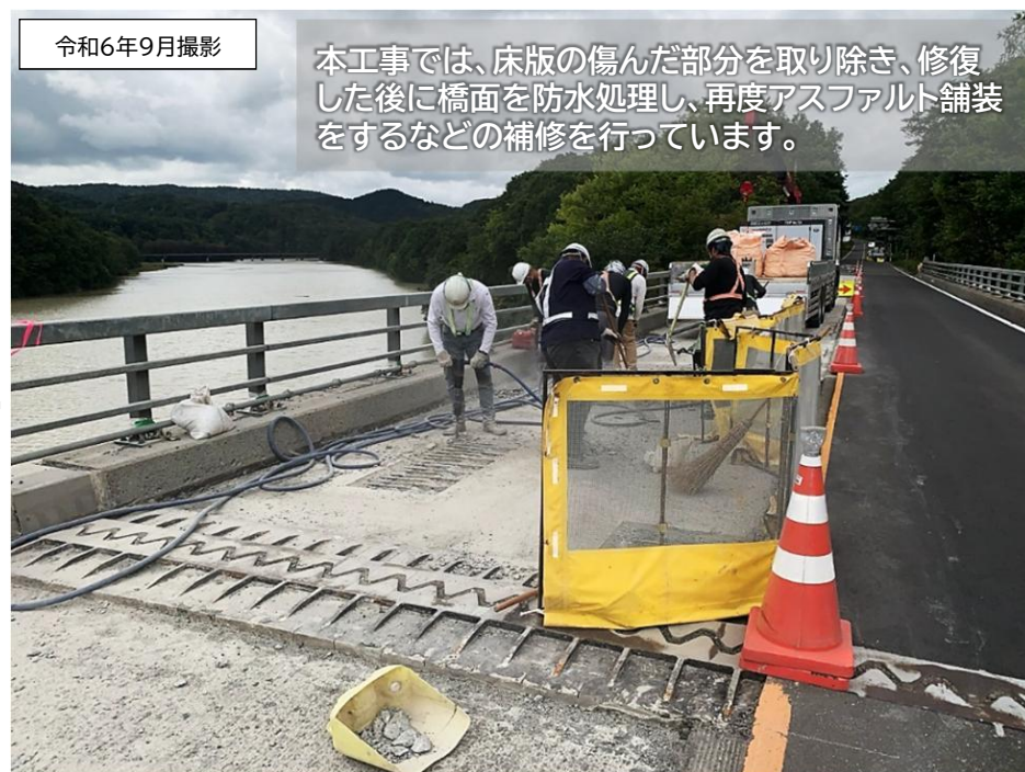
【国道274号 雨霧橋の橋梁補修(夕張市)】
