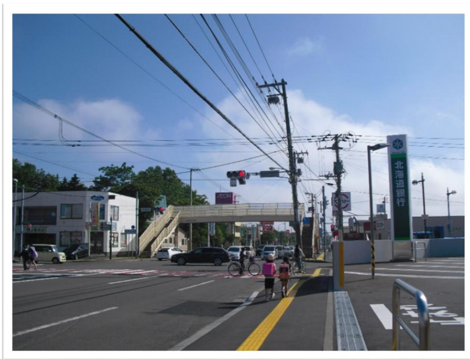
【整備前】(国道12号江別市野幌町)
