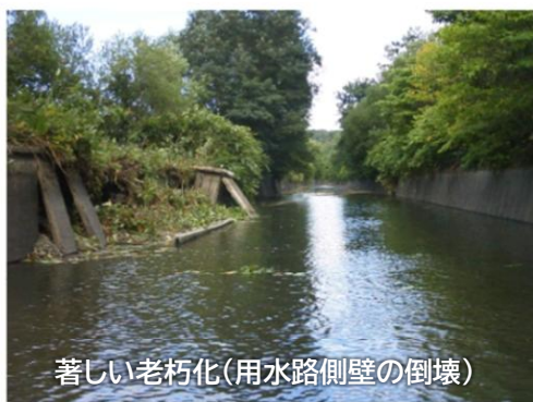
【農業水利施設(用水路)の整備】 国営かんがい排水事業北海地区
