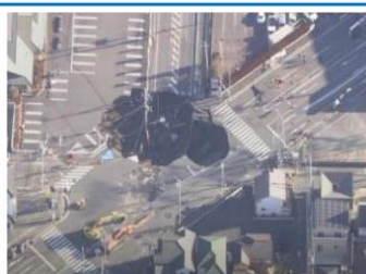
1月31日時点の事故現場の状況
