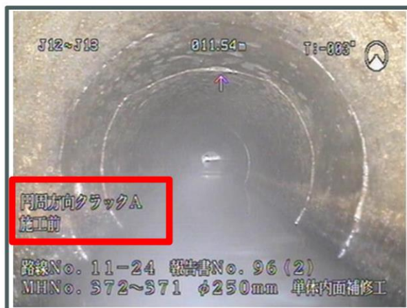
TVカメラによる管内の詳細調査
