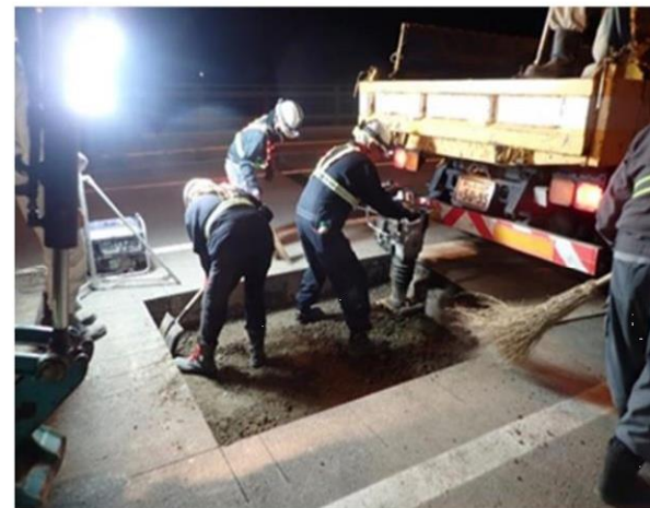
補修状況：国道12号（北海道札幌市）
