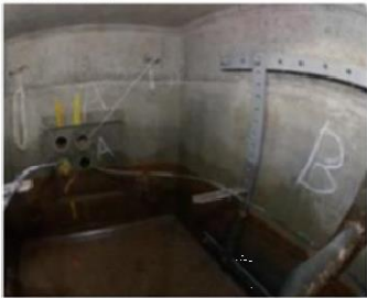
マンホール内写真
