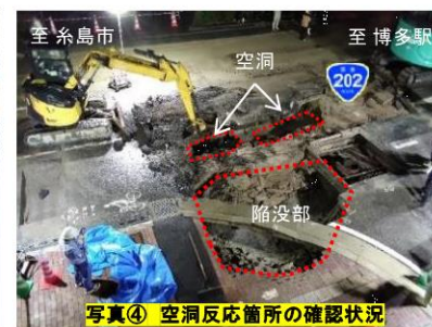
写真④ 空洞反応箇所の確認状況
