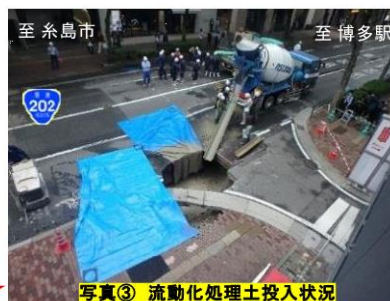
写真③ 流動化処理土投入状況
