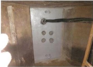
補修後（壁面補修）
