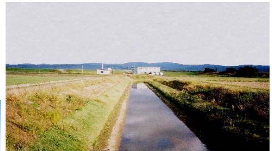
排水不良を解消するための排水路
