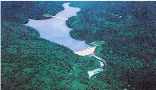
安定した農業用水を確保するダム
