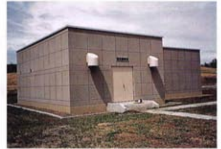
▲導水施設 原水調整池
