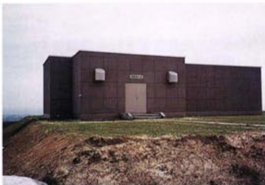
▲配水施設 里見配水池
