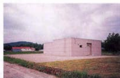
▲取水・導水ポンプ場
