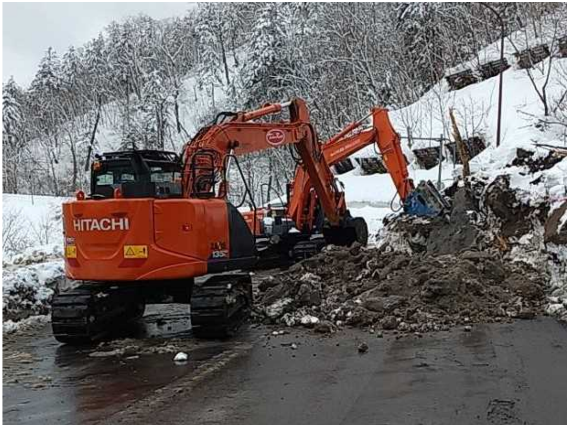
堆雪の他、土石及び倒木の除去作業(国道276号 千歳市美笛)
