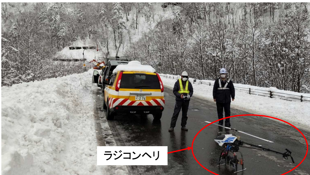
ラジコンヘリを使った斜面調査の状況(国道276号 千歳市美笛)
