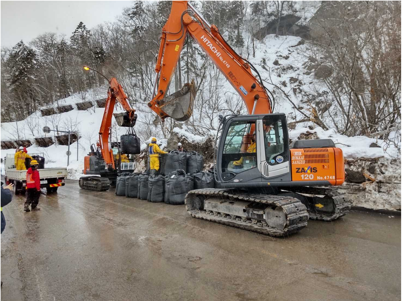
土のう設置作業(国道276号 千歳市美笛)
