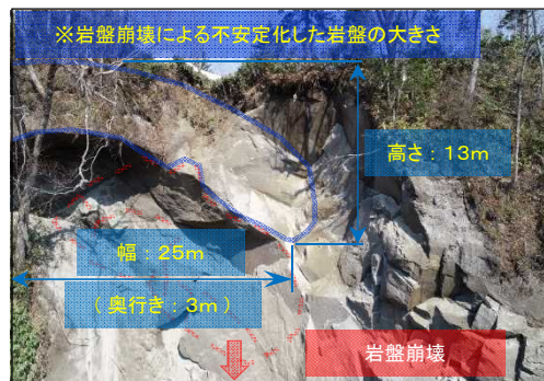
枠内正面写真
