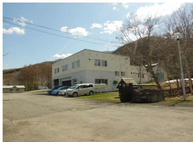
幾春別川ダム建設事業所（外観）
