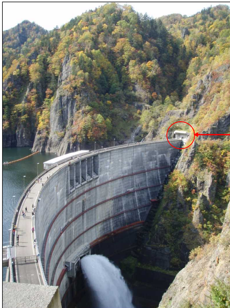
貯蔵実験場所 作業用トンネル
