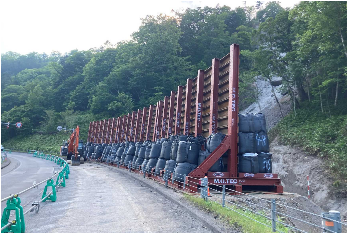
仮設落石防護柵設置作業(国道276号 千歳市美笛)
