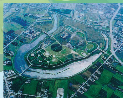
モエレ沼 大雨の時、雨水をためます。
