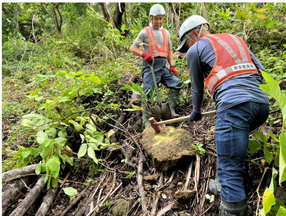
写真_9 / 20 浮き石除去作業状況
