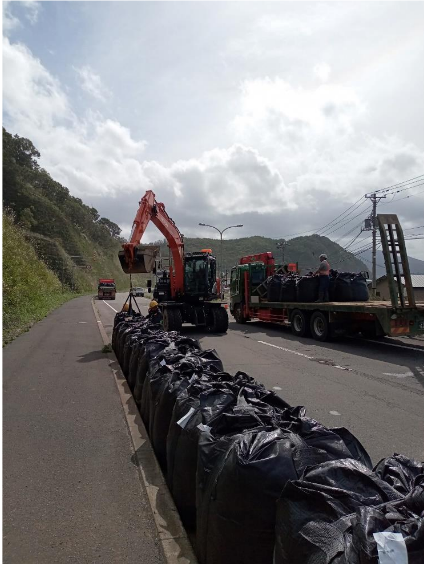
写真_9 / 20 大型土のう設置作業状況
