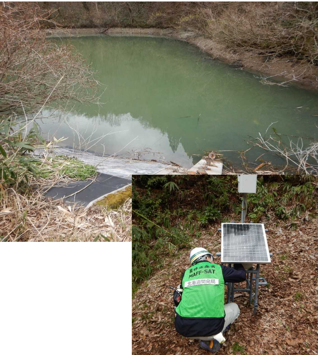
農業用ため池の水位計設置作業
