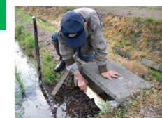
水田の活用（調整板設置状況）
