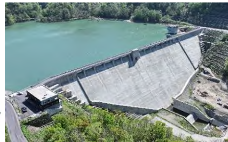
新桂沢ダム (令和6年3月完成)
