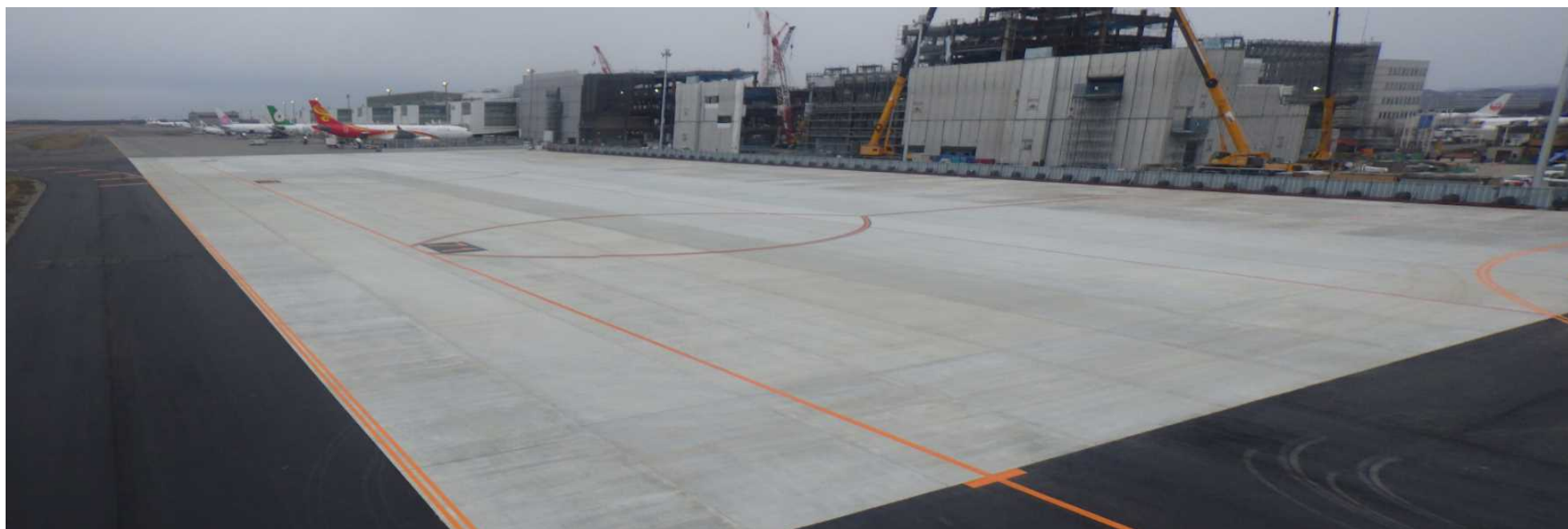
拡張部分完成写真(平成30年12月6日撮影)
