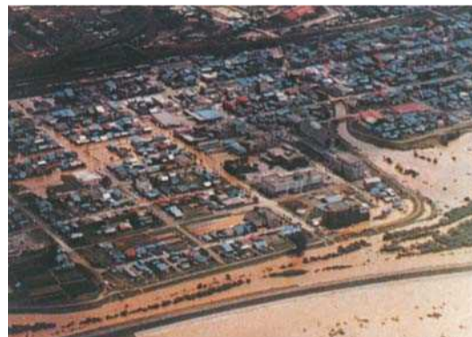
昭和50年洪水 砂川市街の浸水状況
