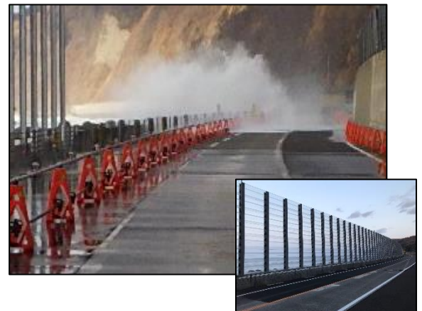
越波対策（越波状況と防波柵設置後）
