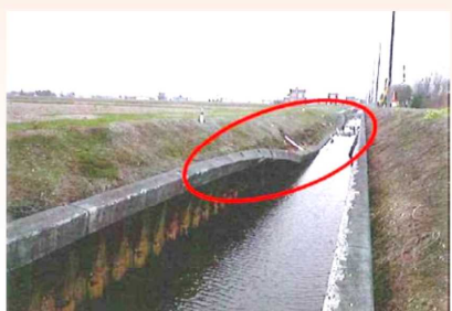
お茶の水第11支線 排水路 護岸の倒壊
