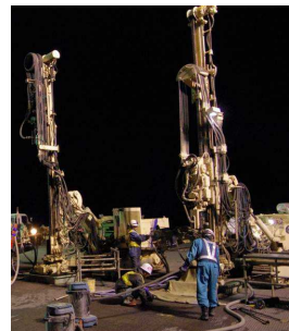
液状化対策による 滑走路等の凹凸防止
