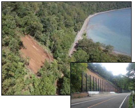
道路斜面对策（被災状況と土砂防護柵設置後）
