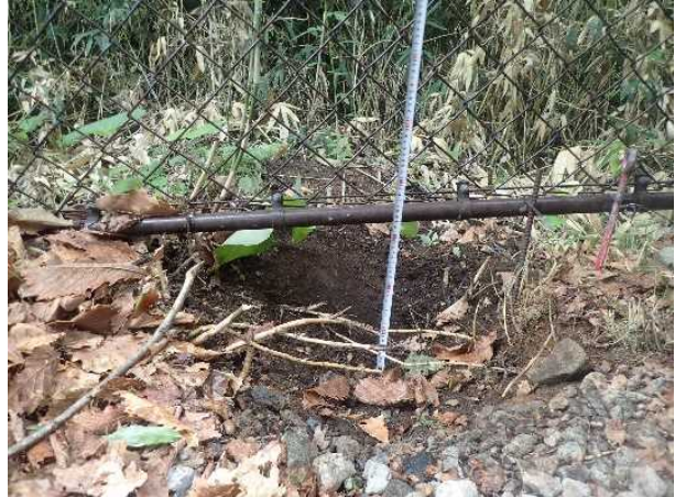
⑥掘跡(侵入箇所:横70cm×縦35cm) 6/22
