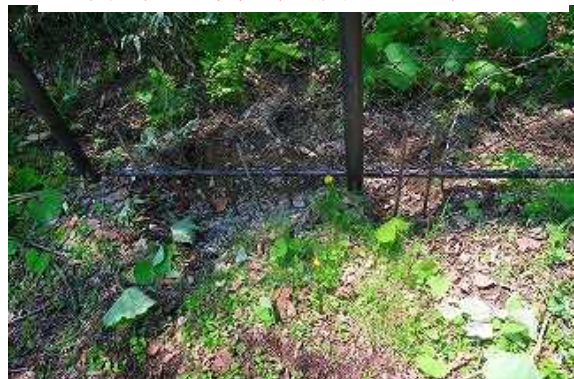
・ 侵入防止対策（鉄筋打ち込み）
