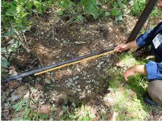
④ 侵入箇所
