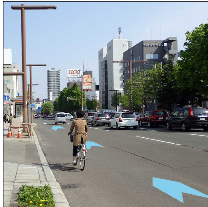
国道230号の整備状況
