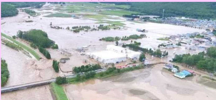
平成28年8月北海道大雨災害時の事例 堤防の決壊
