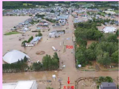
冠水による国道通行止め
