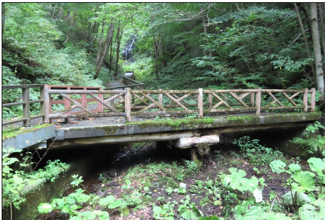
【木コンクリート橋・木直川橋 全景】
