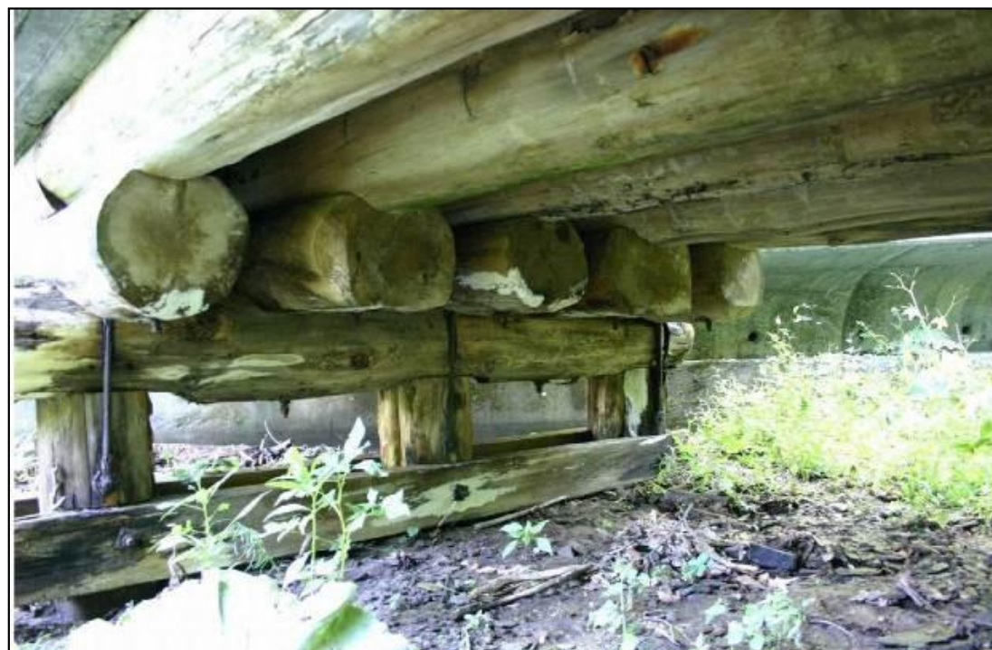
【木コンクリート橋・木直川橋 桁下】
