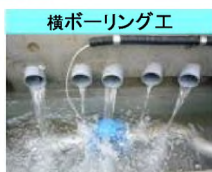
横ボーリング工
