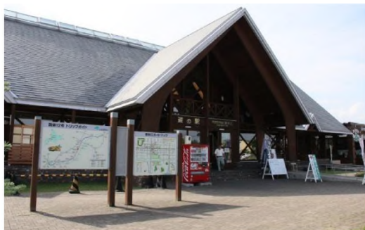
「防災道の駅」として選定した 道の駅「ハウスヤルビ奈井江」
