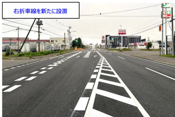
交差点における交通安全対策 (国道12号 砂川市)
