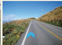
急カーブ手前
